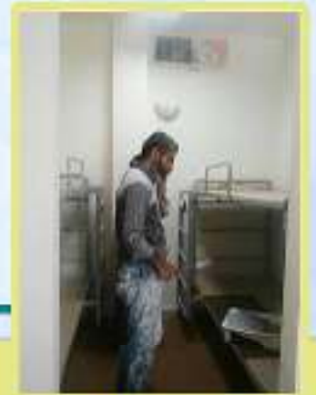
رنگ آمیزی حفاظ و سنگ سابی کناره های تیز تخت های خوابگاه ترگس
