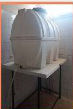
تهیه و نصب منبع آب شیرین جهت سلف سرویس دانشکده دندانپزشکی
